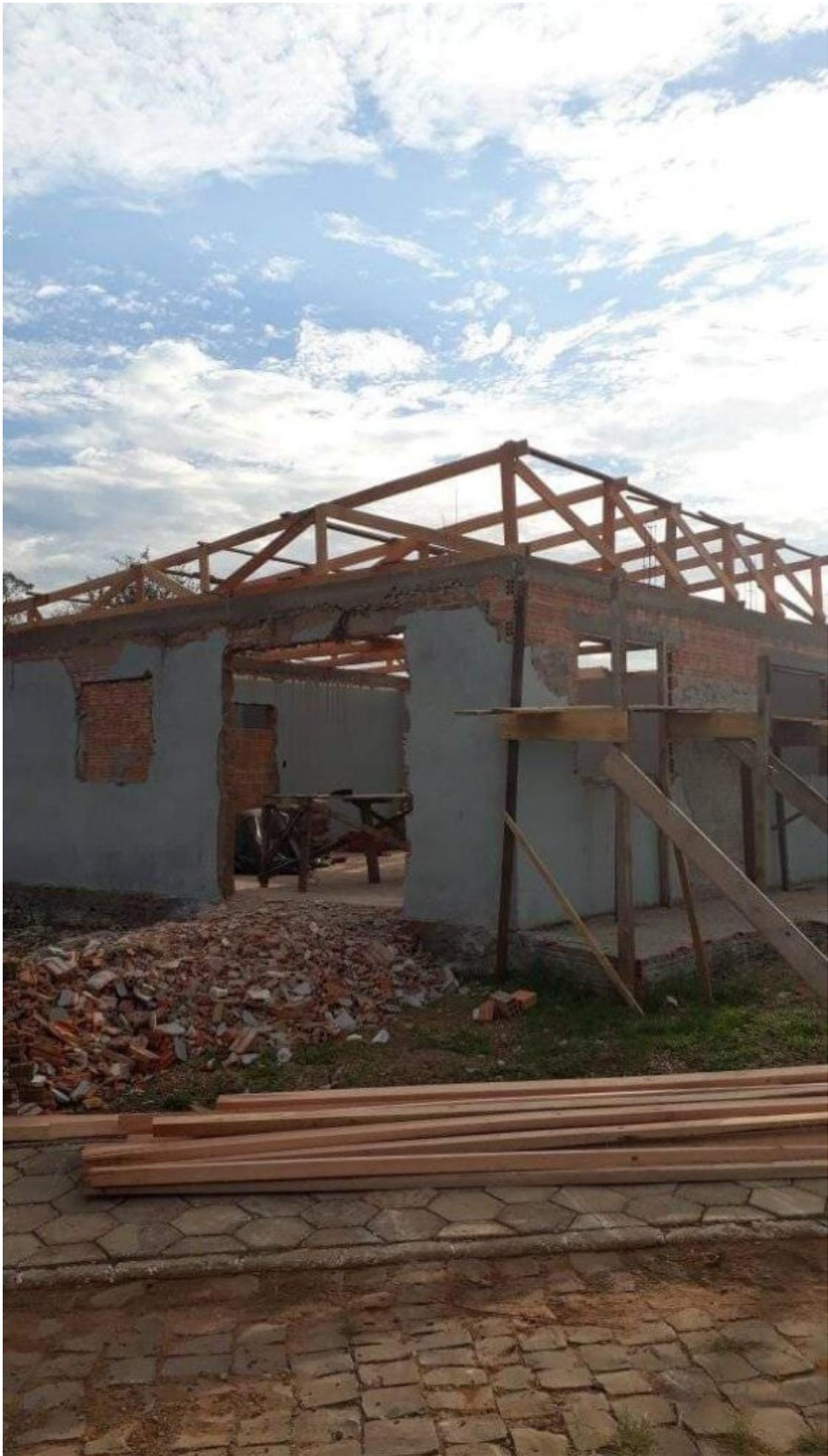
A reforma da capela velatória está em pleno andamento. As paredes já foram levantadas e as tesouras estão sendo colocadas. Também ganhará aberturas em vidros, novo piso, forro, pintura e climatização. A obra é executada com recursos próprios da Prefeitura e a conclusão deve ocorrer em até 60 dias.
